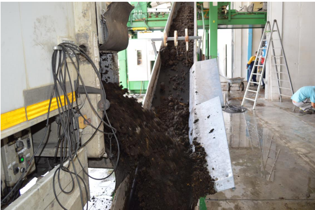
Il nuovo sistema in fase di scarico.
